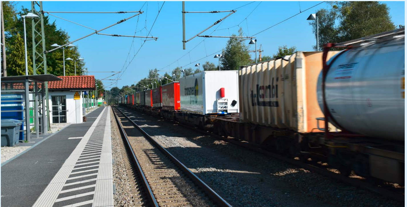
21 Kilometer Ortsdurchfahrten gibt es an der Bestandsstrecke. Sie wurde vor rund 160 Jahren gebaut.
