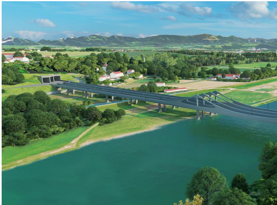
Bereich Innleiten mit Innbrücke und Tunnelportal
