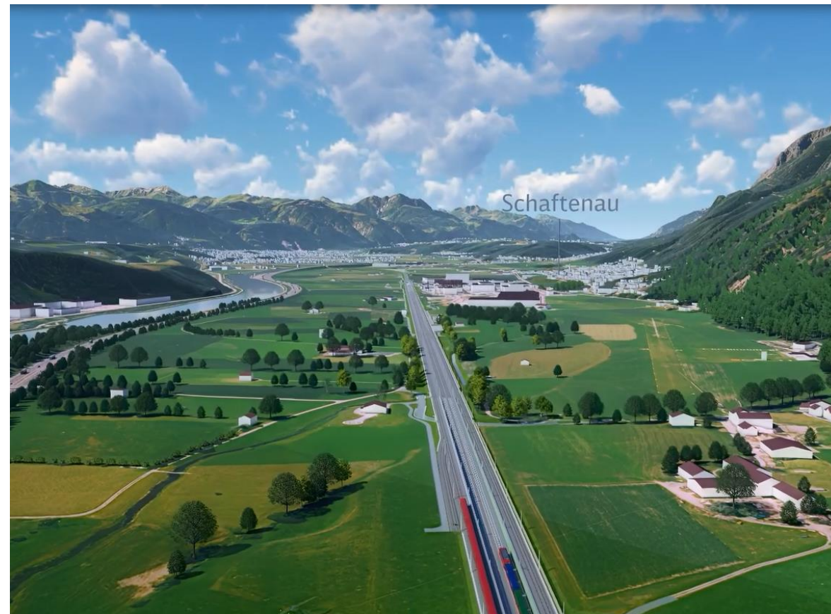
Bereich der freien Strecke Richtung Schaftenau
