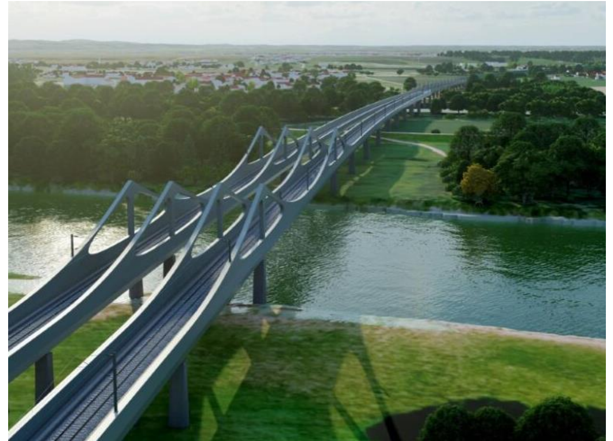
Brücke über den Inn, EÜ Langenpfunzen
